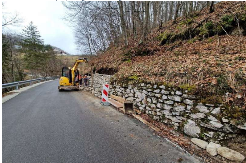
Slika 48: Obnovitev podpornega zidu ob Triglavski ulici
