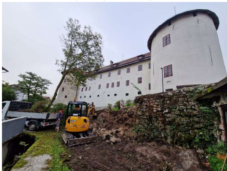
Slika 47: Obnovitev podpornega zidu pri gradu Gewerkenegg
