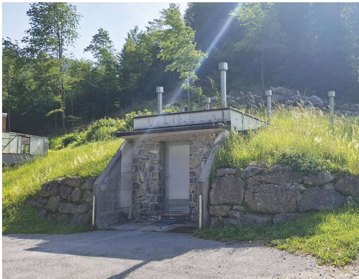
Slika 31: Vodohran Idrijska Bela
