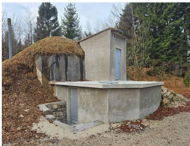
Slika 1: Obnovljen vodohran na Vojskem
